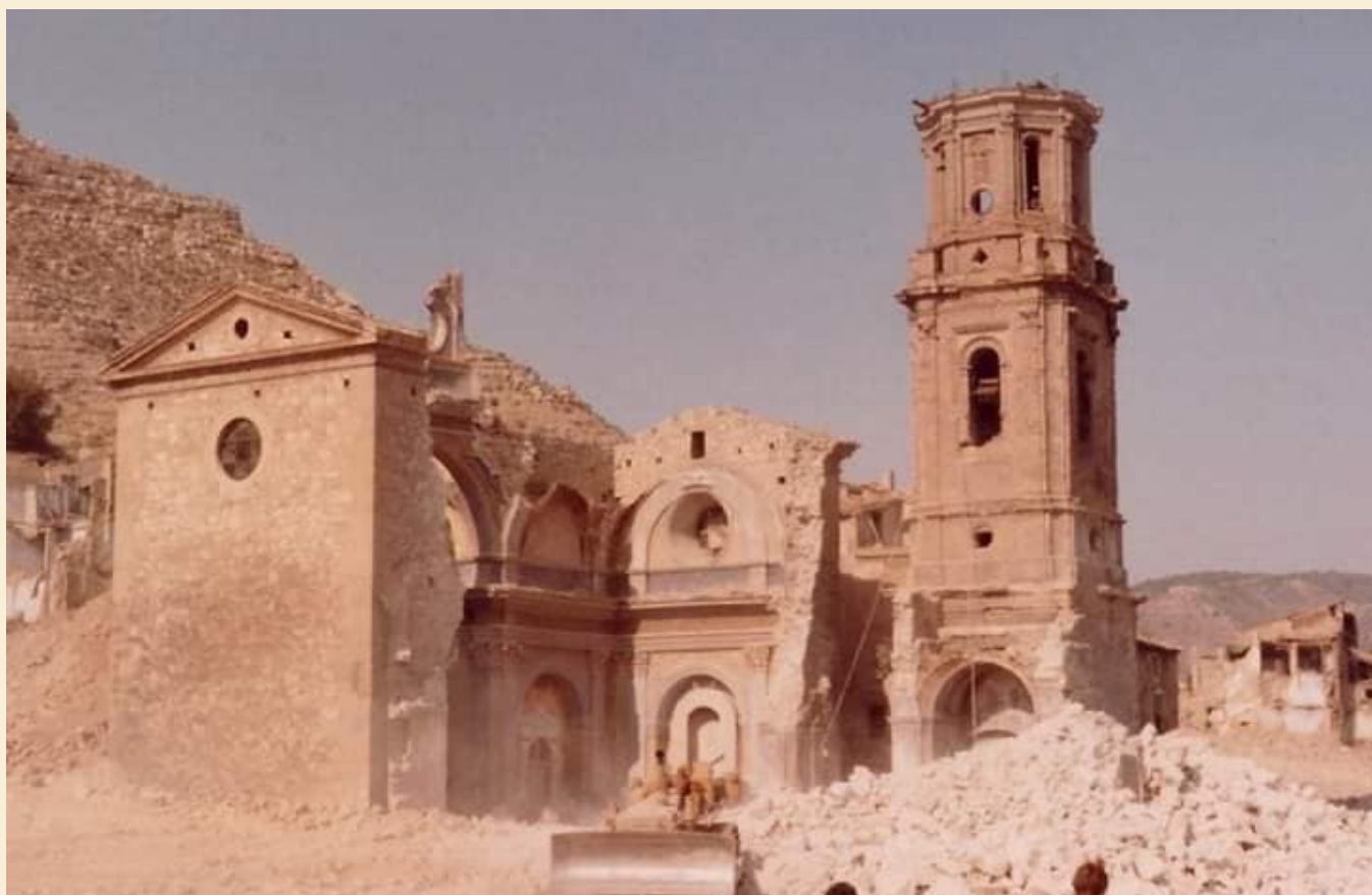
Destrucció de l'església del Poble vell.
