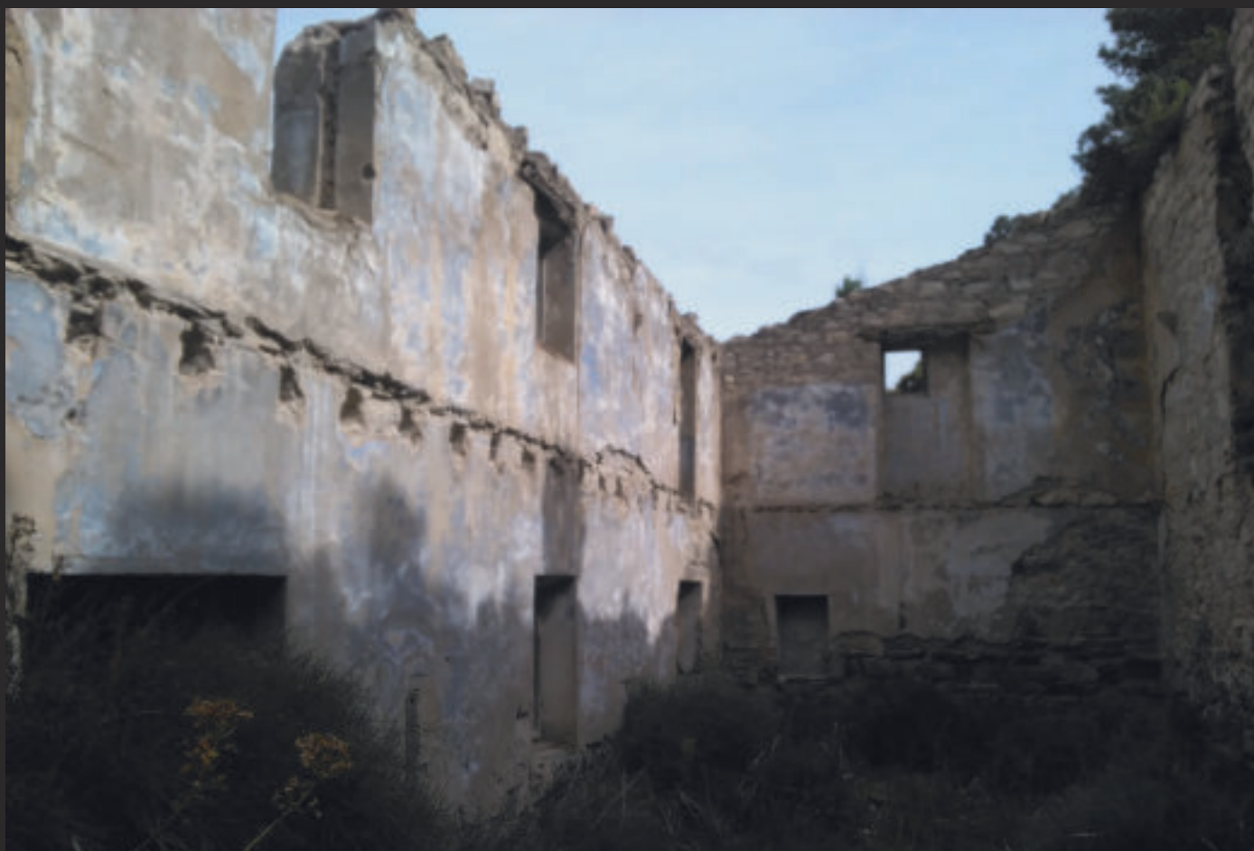
A sota edifici en ruïnes de la mina Previsión. Destaca l'existència d'una porta en la roca que dona accés al laberint subterrani.
