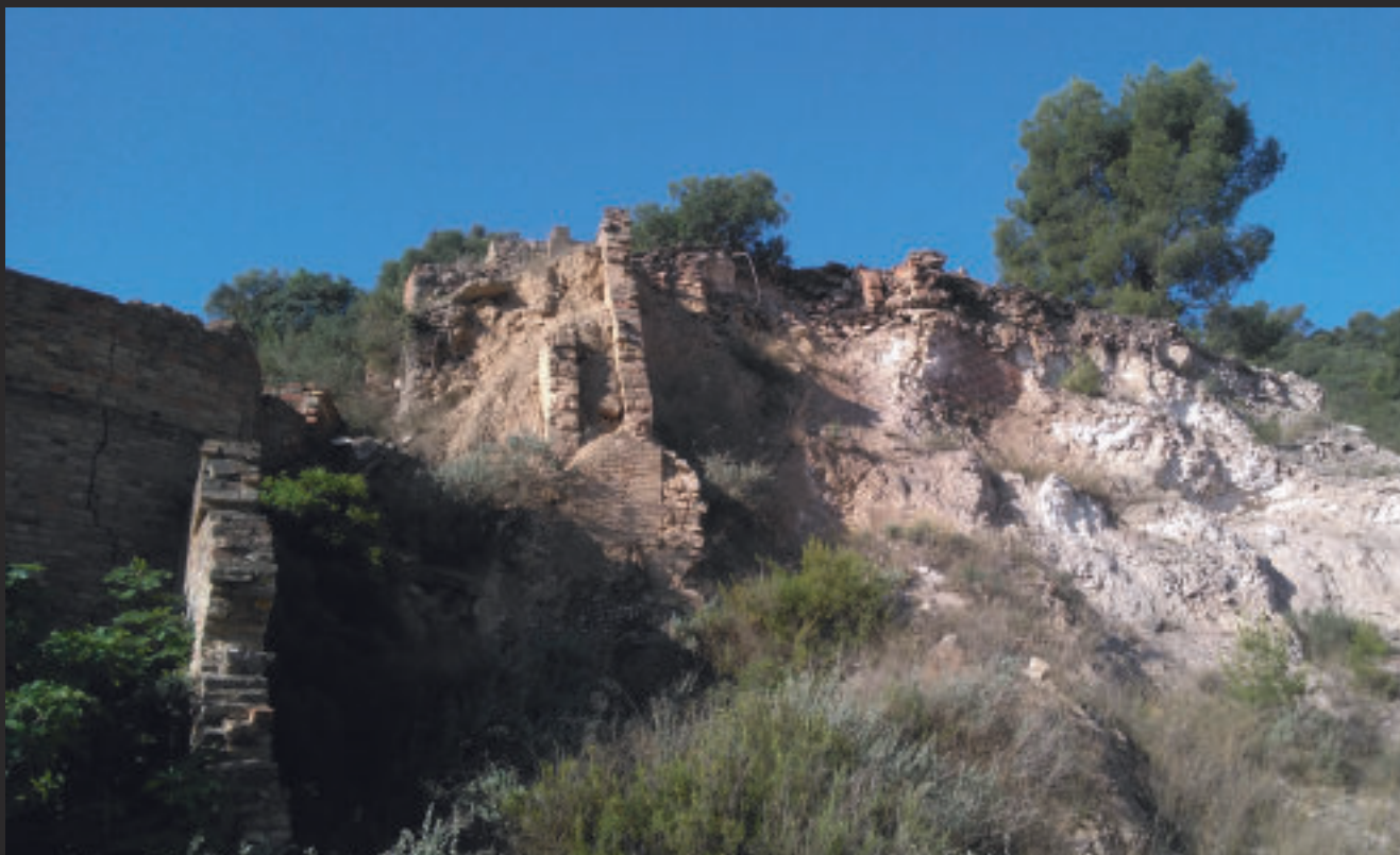
Restes de part del carregador, malacate (tub de descens del carbó) i edificacions de la mina Petra
