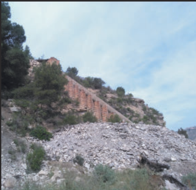
A dalt, tub de descàrrega de lignit de la mina Previsión.
