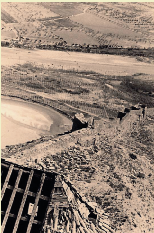
Torres adosades a la muralla islàmica
